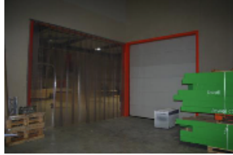
Afdichting tussen hallen
